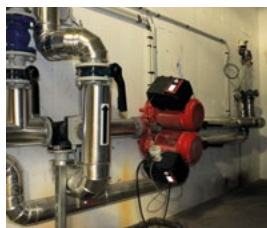
Circuit primaire reliant la piscine aux thermes – système de géothermie
