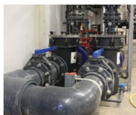
Préfiltres et pompes – filtres à sable principaux – tableau de surveillance
