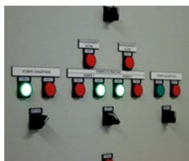
Préfiltres et pompes – filtres à sable principaux – tableau de surveillance
