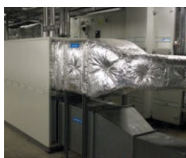
Système de filtration d'air
